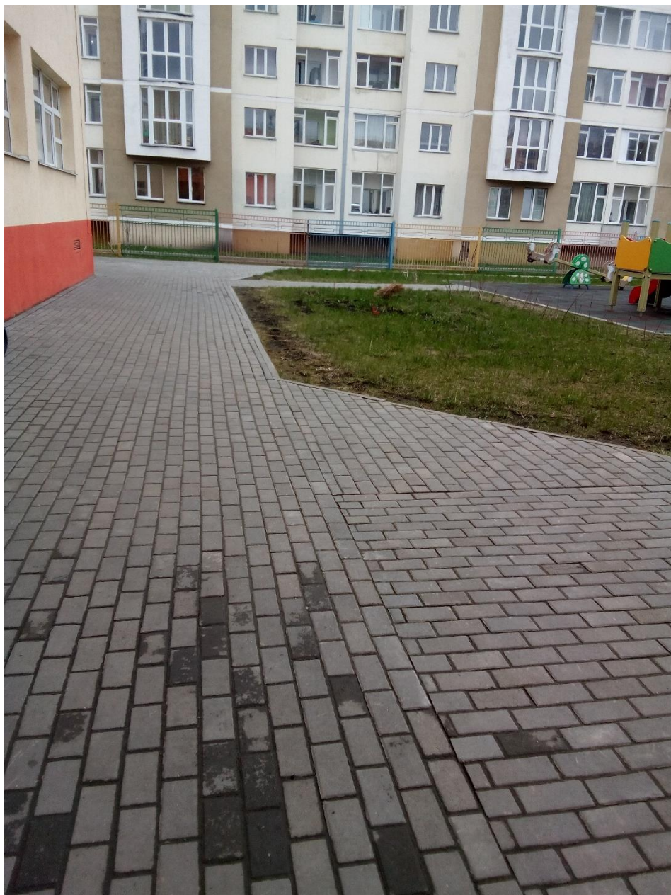
Тротуар к главному входу Фото № 3
