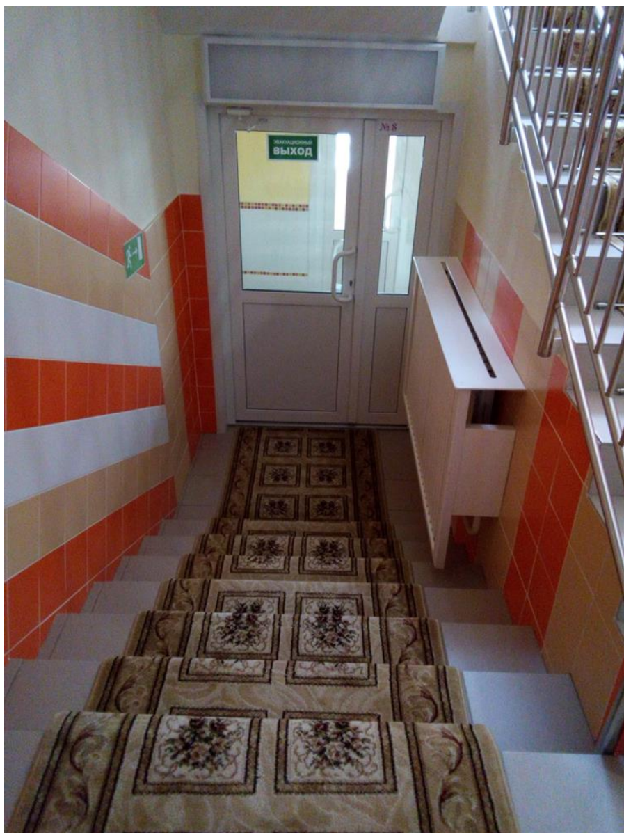
Эвакуационный выход блок «В» фото №24
