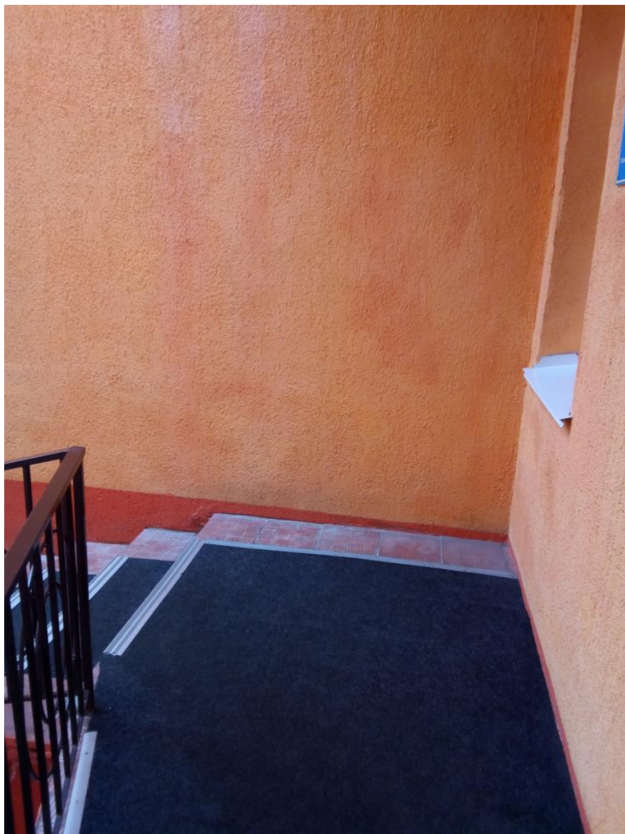
Крыльцо главного входа фото № 7
