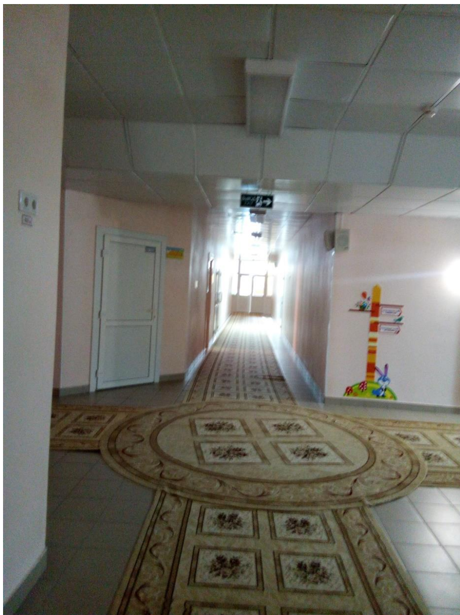
Коридор 2 этаж блок «А» фото №28
